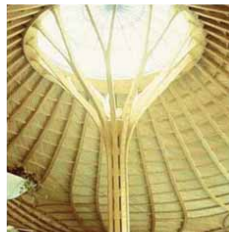
Figura 9 Cobertura de uma piscina - Árvore de Glulam em Bad Dürrenheim, Alemanha
