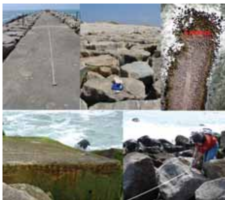
Figura 1. Exemplo de aplicação da técnica de amostragem linear no manto resistente da estrutura de protecção costeira.
