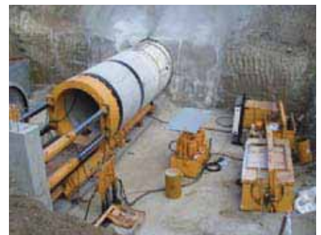
Fig. 4 – Equipamento de perfuração dirigido por laser
