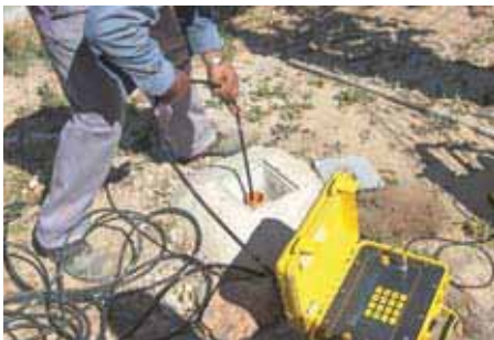
Figura nº 16 Inclinómetro, para monitorização, da estabilidade do terreno, na zona confinante com o caneiro. Este sistema detecta desvios de verticalidade do terreno, no interior dos terrenos, adjacentes ao caneiro.
