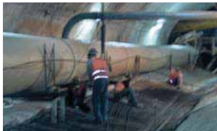
Figura nº 9 Execução de soleira em betão armado. Condutas de desvio de esgoto.
