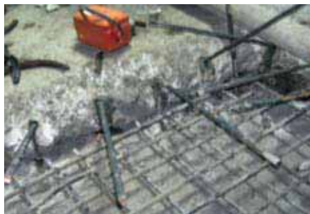
Figura nº 8 Remoção da soleira em betão e execução de nova, em betão armado (utilização de ferrolhos e produto epoxi para ligação de betão velho a betão novo).
