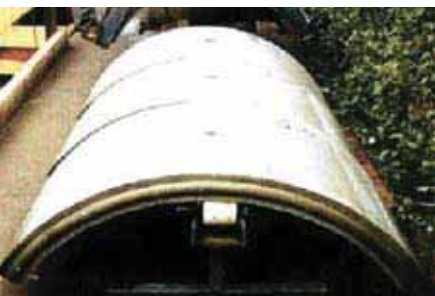
Fig. 6 – Equipamento para transporte e instalação do revestimento
