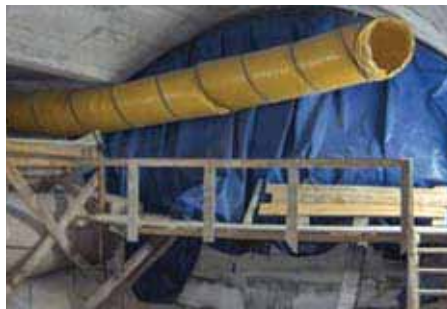
Figura nº 7 Diques e condutas, com sistema de ventilação, criando condições de execução da soleira e de controlo de qualidade do ar.
