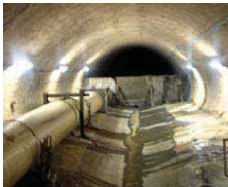
Figura nº 19 Obras concluídas, com substituição das soleiras, tratamento de fendas e fissuras e consolidação dos terrenos, exteriores ao caneiro.
