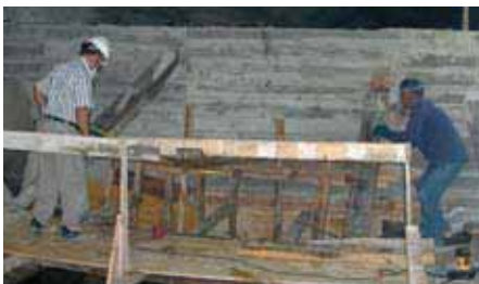
Figura nº 6 Construção de diques e condutas para desvio do esgoto.
