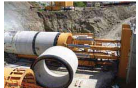
Fig. 5 – Equipamentos para instalação de tubagens pelo método de pipe jacking
