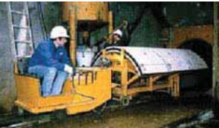
Fig. 6 – Equipamento para transporte e instalação do revestimento
