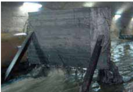
Figura nº 9 Execução de soleira em betão armado. Condutas de desvio de esgoto.
